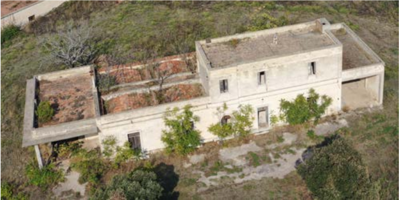
7. - Edificio 1, foto generale (foto da drone A. Palermo, ottobre 2022).
