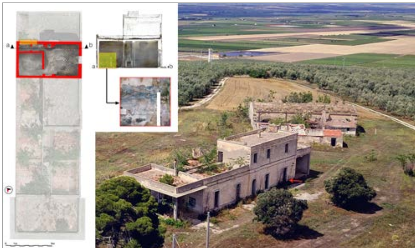
12. - Veduta aerea e rilievi dell'edificio 1: localizzazione dell'ambiente e del dipinto.
