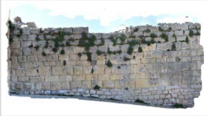
7. - Castello: fotocomposizione di un tratto murario (elaborazione A. Cardone, R. Giuliani).
