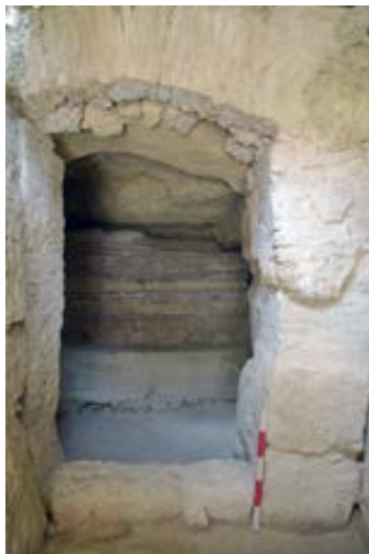
5. - Ipogeo F: visione dalla galleria dell'arco d'ingresso al cubicolo con funzione di sostegno e consolidamento (foto 2019 dopo gli interventi conservativi; da Coemeteria Requiere I 2023).
