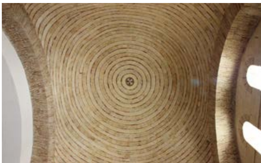
5. - Cattedrale di San Sabino: una delle cupole della chiesa del VI secolo, con l'impiego di mattoni sabiniani (foto dell'A.).
