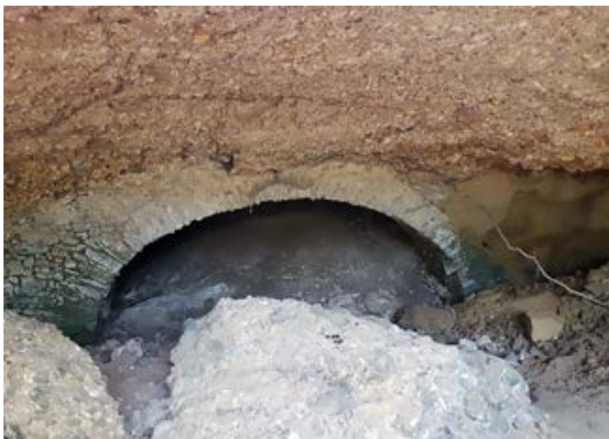
4. - Acquedotto di Montemilone, masseria Perillo Soprano. Arco con fori per il troppopieno (foto A. Scaliero 2018_archivio Soprintendenza ABAP della Basilicata).
