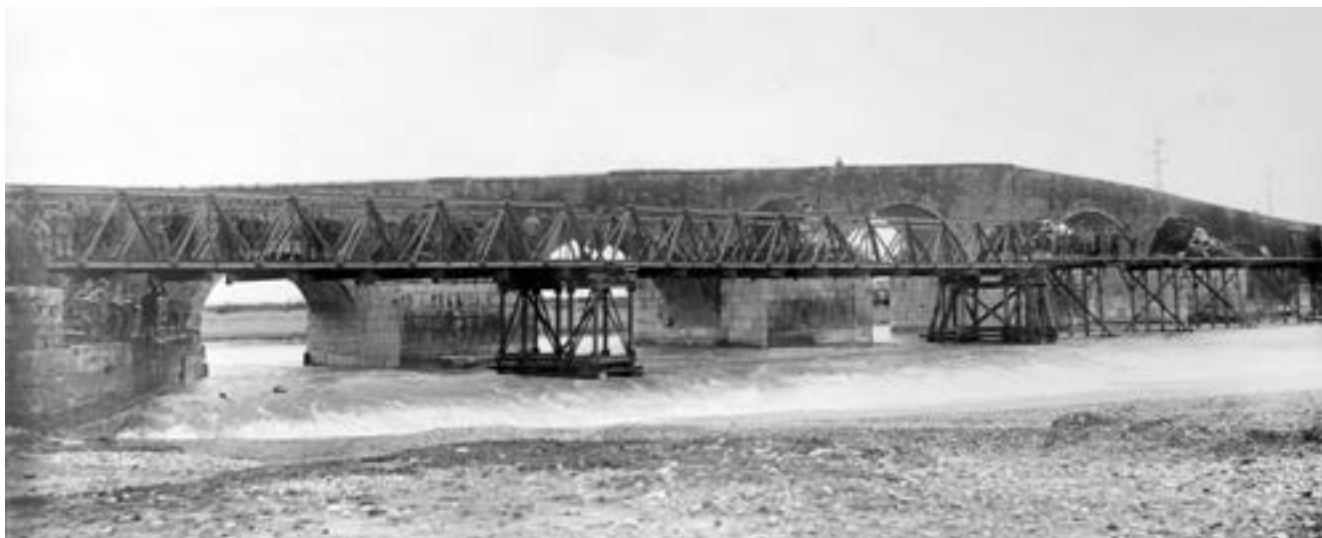
6. - Il ponte provvisorio costruito a monte di quello in muratura. La foto riporta la seguente didascalia: “9° Genio. Ponte Herbert gittato sul fiume Ofanto. 18-4-30”. Archivio Pasquale Ieva.
