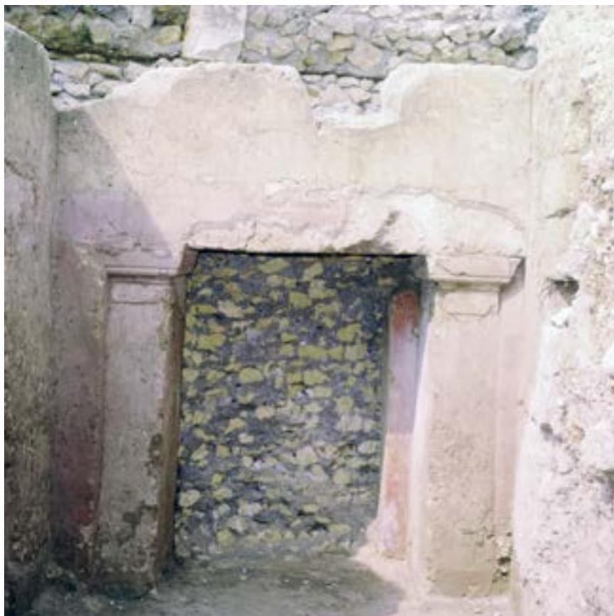
1. - Fondazioni in opus caementicium inglobate nella camera funeraria dell'Ipogeo 21.
