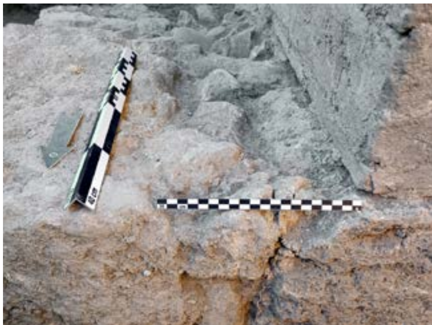
8. - Particolare delle fondazioni Saggio II.
