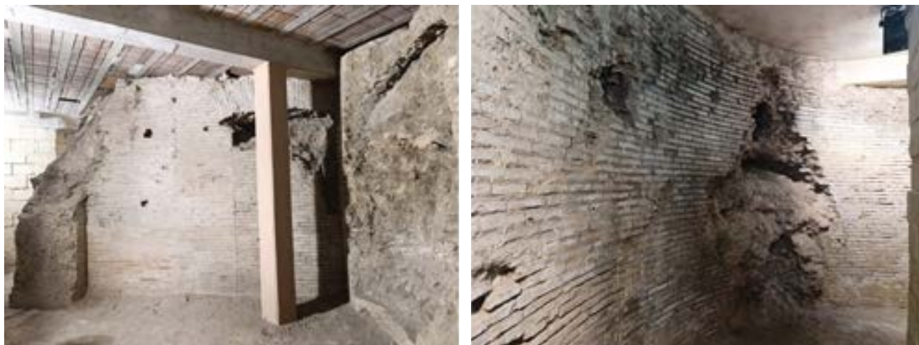
10. - Strutture murarie del caldarium delle Terme Ferrara (foto dell'A.).
