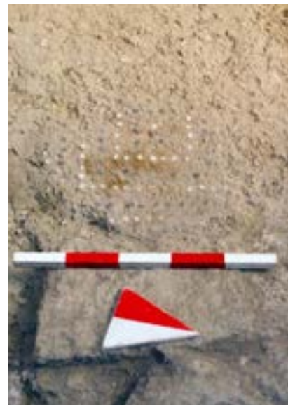
6. - Particolare del rivestimento pavimentale in opus signinum nell'area ricavata dopo l'abbattimento del setto divisorio tra gli amb. 3 e 4.
