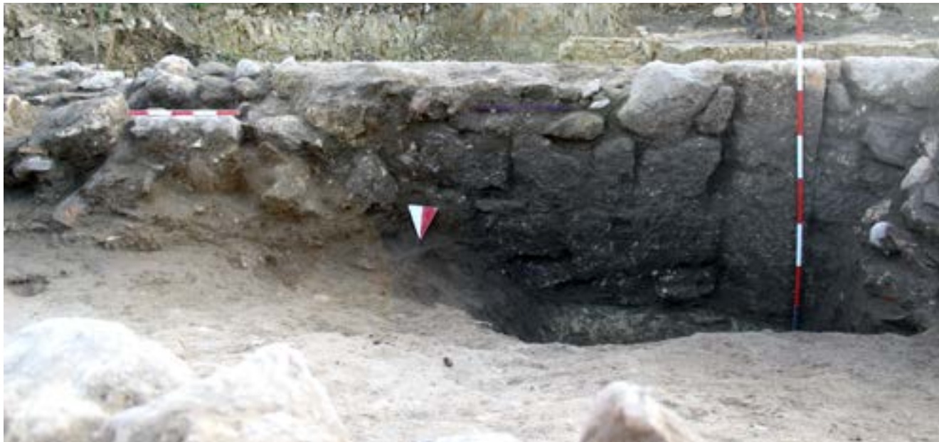
6. - Scavi 2020-2021: prospetto nord dell'USM 14 con, sulla sinistra, il crollo parziale del paramento (Archivio SABAP BAT-FG).
