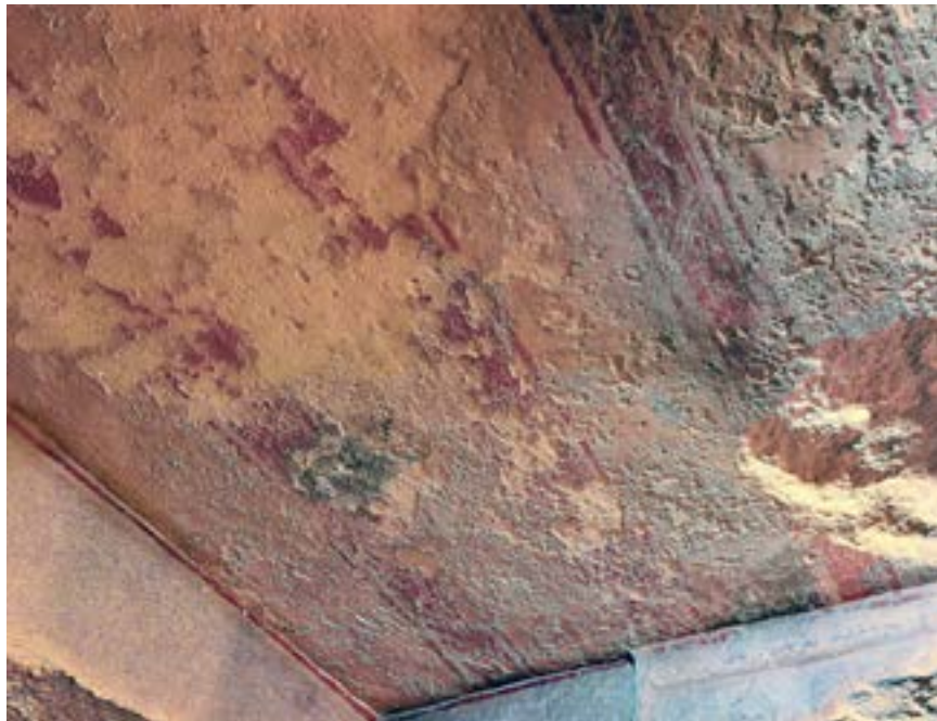
8. - Rielaborazione da 3D Model di V. Fabiano su piattaforma Sketchfab con particolare delle travi profilate sul soffitto del vestibolo atrio della Tomba Scocchera B (rielaborazione dell'A.).
