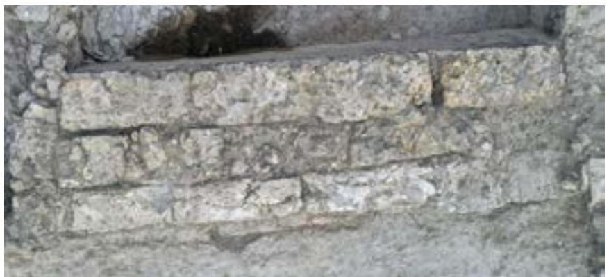
6. - Vista dall'alto del tratto di canalizzazione più settentrionale (foto M. Potenza).
