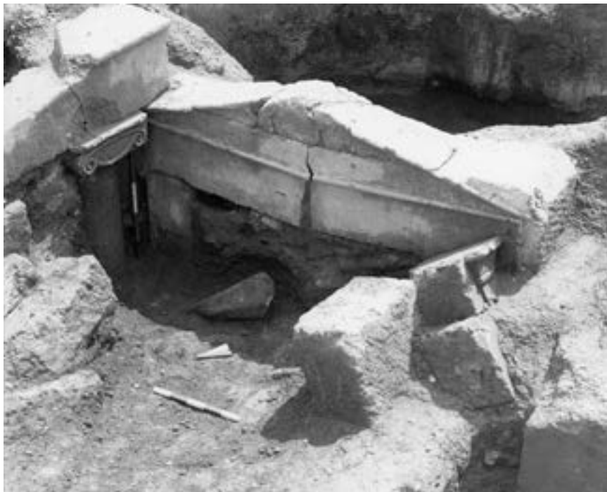
16. - Area del vestibolo con dissesto e situazione di crollo degli elementi architettonici delle camere B e C. In evidenza l'articolazione del blocco architrave-frontone della camera B.
