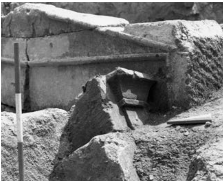
17. - Posizione di caduta del capitello tuscanico del pilastro a destra dell'ingresso della camera C.
