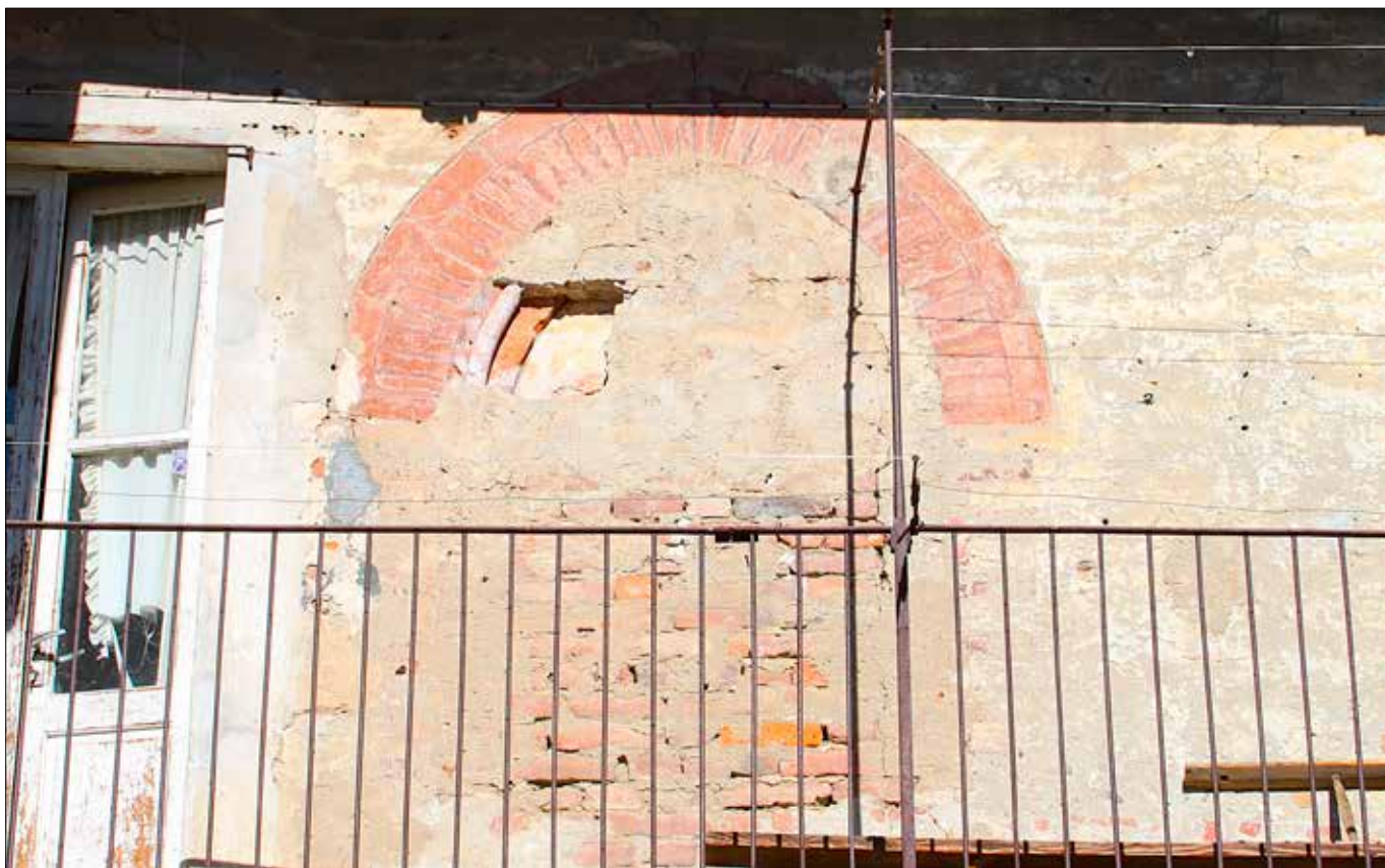
Fig. 5. - Dettaglio di uno degli archi di finestra conservati sul fronte murario della grangia di Lagnasco.
