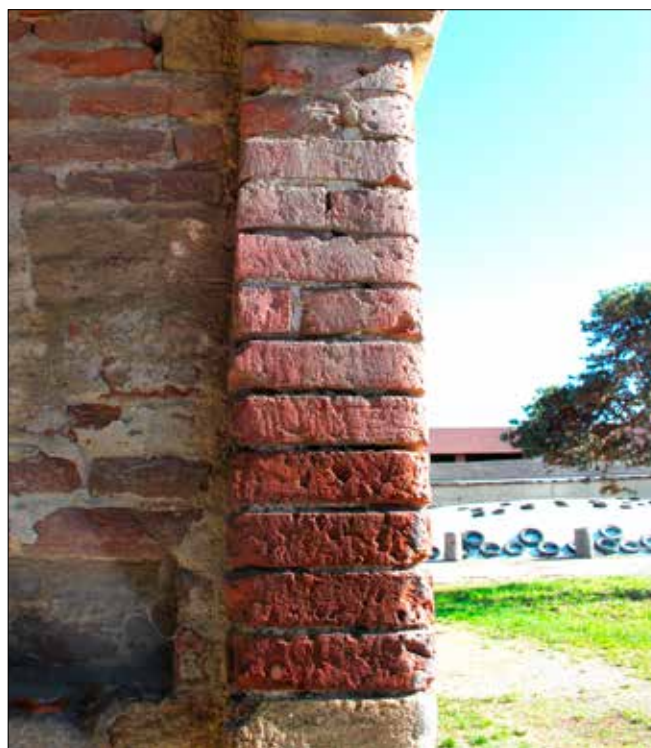
Fig. 6. - Dettaglio dello stipite dell'arco monumentale della grangia di Lagnasco.
