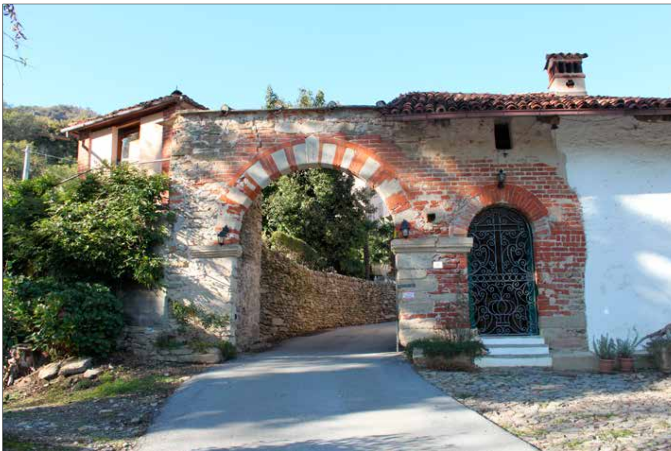
Fig. 7. - Arco monumentale e fronte murario della grangia di Envie-Torriana.
