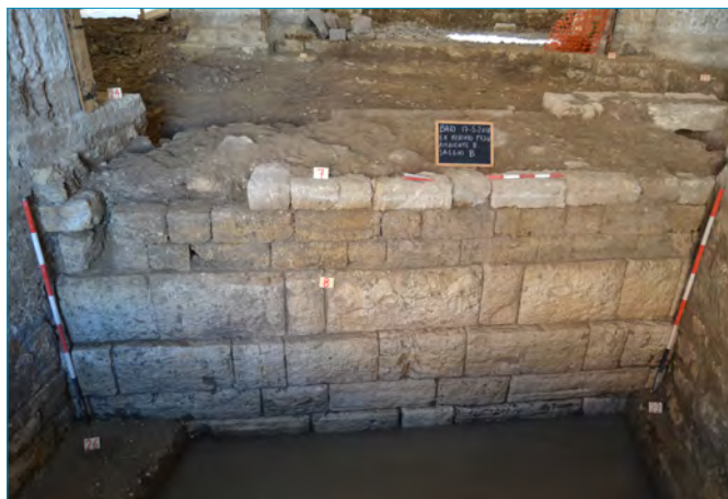
Fig. 12 - Ambiente 8. Saggio B, con il paramento esterno del "muro a mare" del Mercato ottocentesco (USM 7), impostato sulla banchina (USM 8, 58).
