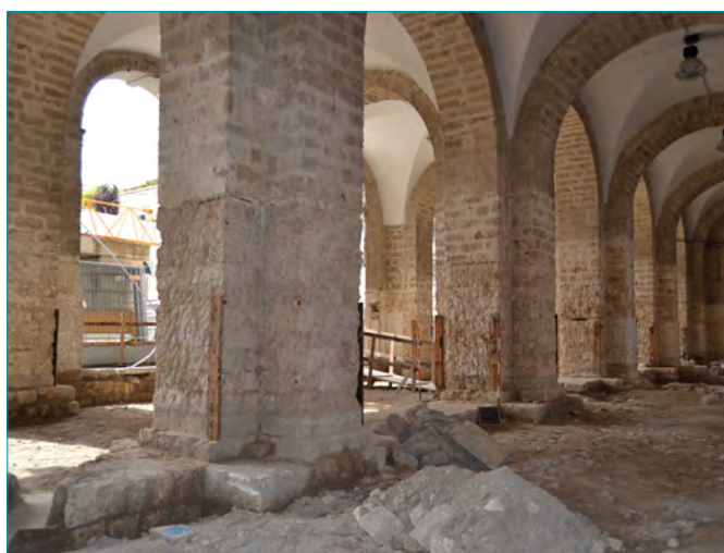
Fig. 8 - Ambiente 8. Veduta dello stato dei luoghi con gli strati di riempimento sottostanti alla pavimentazione.
