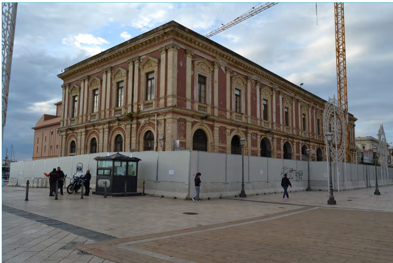
Fig. 2 - Bari, Mercato del Pesce. Veduta da nord-ovest durante i lavori di ristrutturazione.
