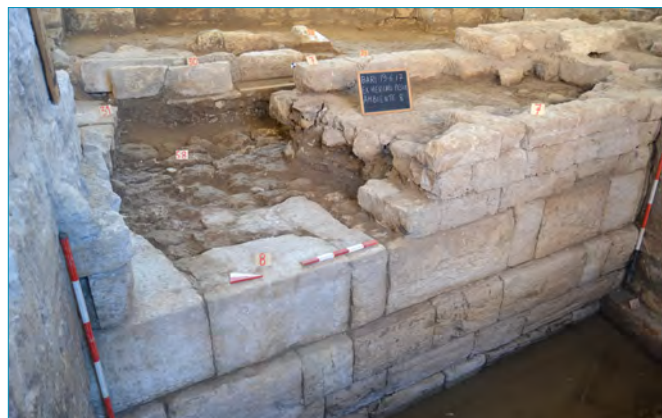
Fig. 23 - Ambiente 8. Veduta da nord-est della banchina (USM 8, 58), dopo la parziale rimozione delle strutture di fondazione dell'edificio mercatale ottocentesco (USM 7).
