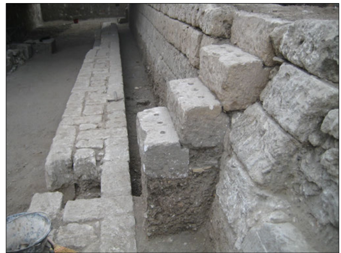
32. - Ex Convento di Sant'Antonio, muri di terrazzamento del convento e del carcere con blocchi di reimpiego.
