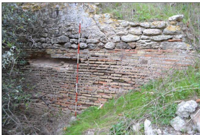
19. - Masseria San Pietro. Muro in opus latericium .
