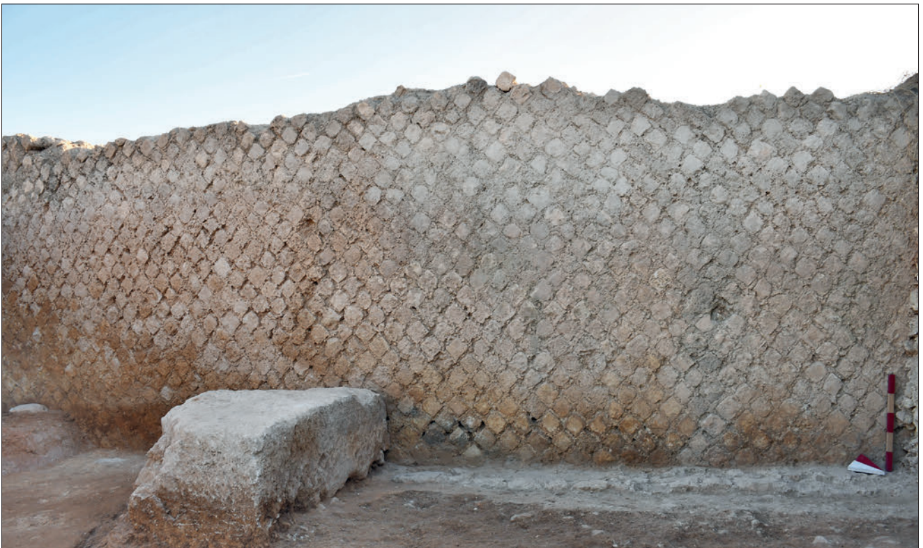
13. - Dettaglio del muro perimetrale dell'anfiteatro romano (foto G. Volpe).
