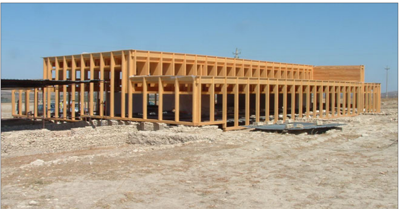
10. - Vista del processo costruttivo della struttura in legno.
