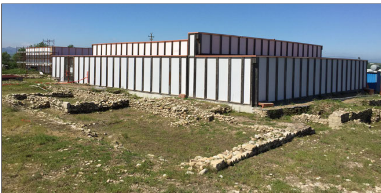
7. - La struttura di protezione e di visita realizzata a Faragola, nella fase conclusiva della vicenda esemplare di un'area archeologica che in tempo reale era stata riportata in luce, studiata, protetta e resa fruibile al pubblico.
