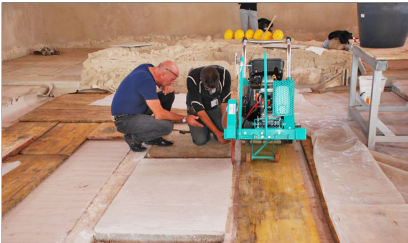
7. - Operazione di distacco dei pannelli in opus sectile della cenatio a cura del ICR del MiC (foto cortesia Maria Laurenti).
