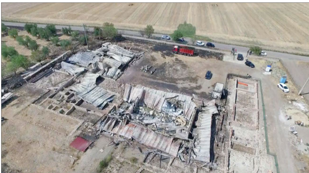
8a-b - Panoramica dell'area distrutta nel settembre scorso. Il pavimento a mosaico della palestra della villa tardoromana appare letteralmente esploso per le alte temperature del rogo.
