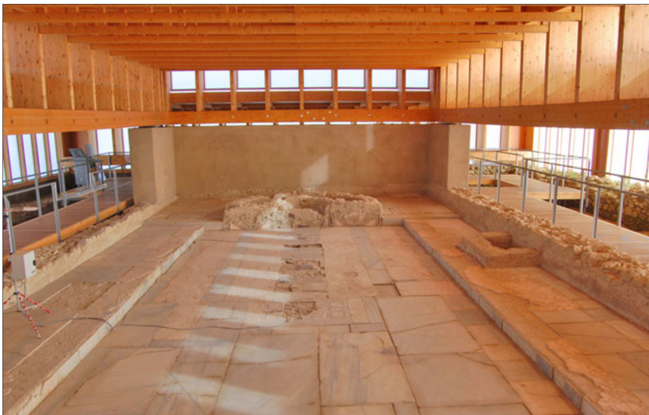
1. - Faragola (Ascoli Satriano), stibadium e cenatio della villa tardoantica (prima del recente incendio che ha distrutto le coperture) (foto G. Volpe).
