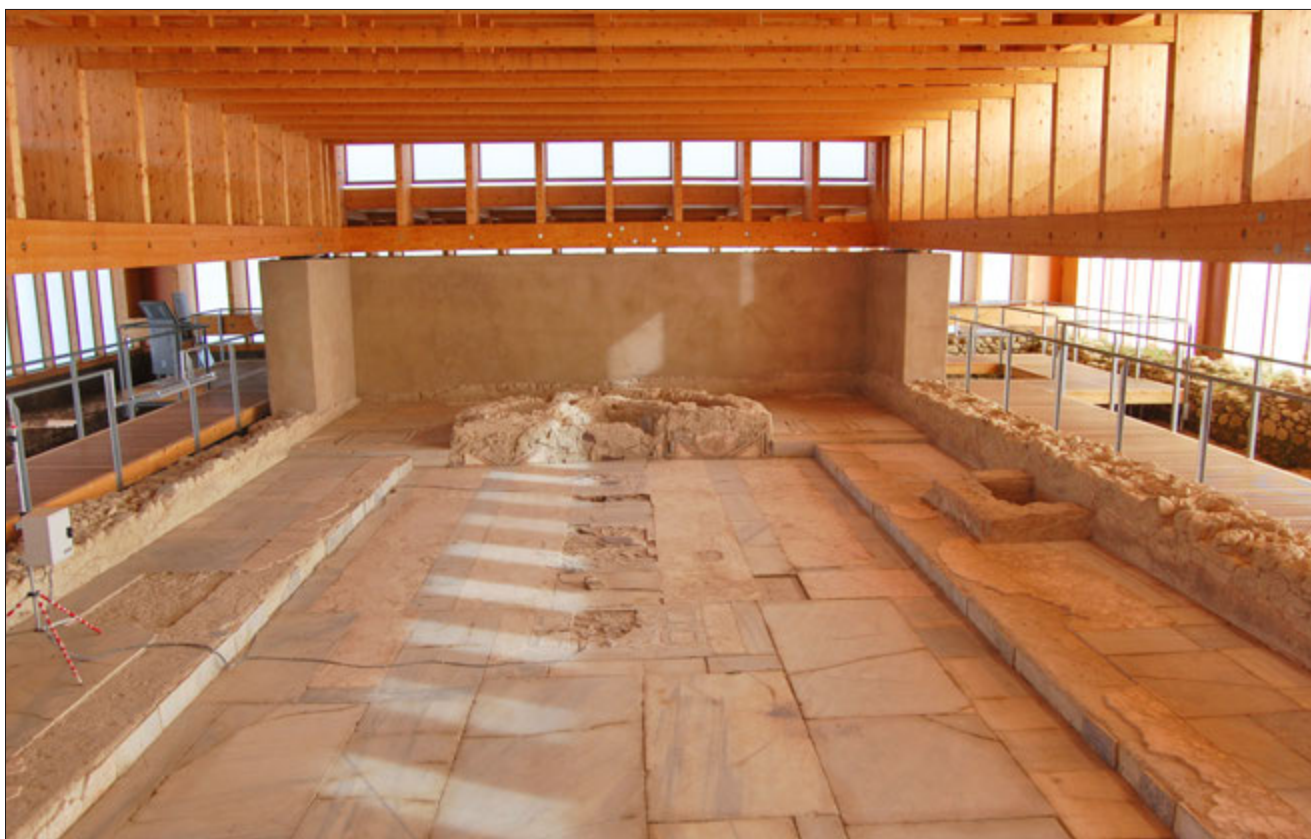
1. - Faragola (Ascoli Satriano). La cenatio musealizzata (prima dell'incendio che ha distrutto le coperture) (foto G. Volpe).
