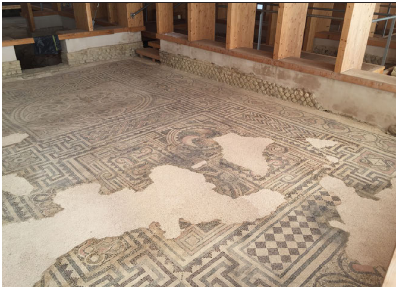
6. - Un settore degli ambienti termali di Faragola con mosaici pavimentali policromi a disegni geometrici (fine IV-V sec.) all'interno delle strutture di copertura andate distrutte.
